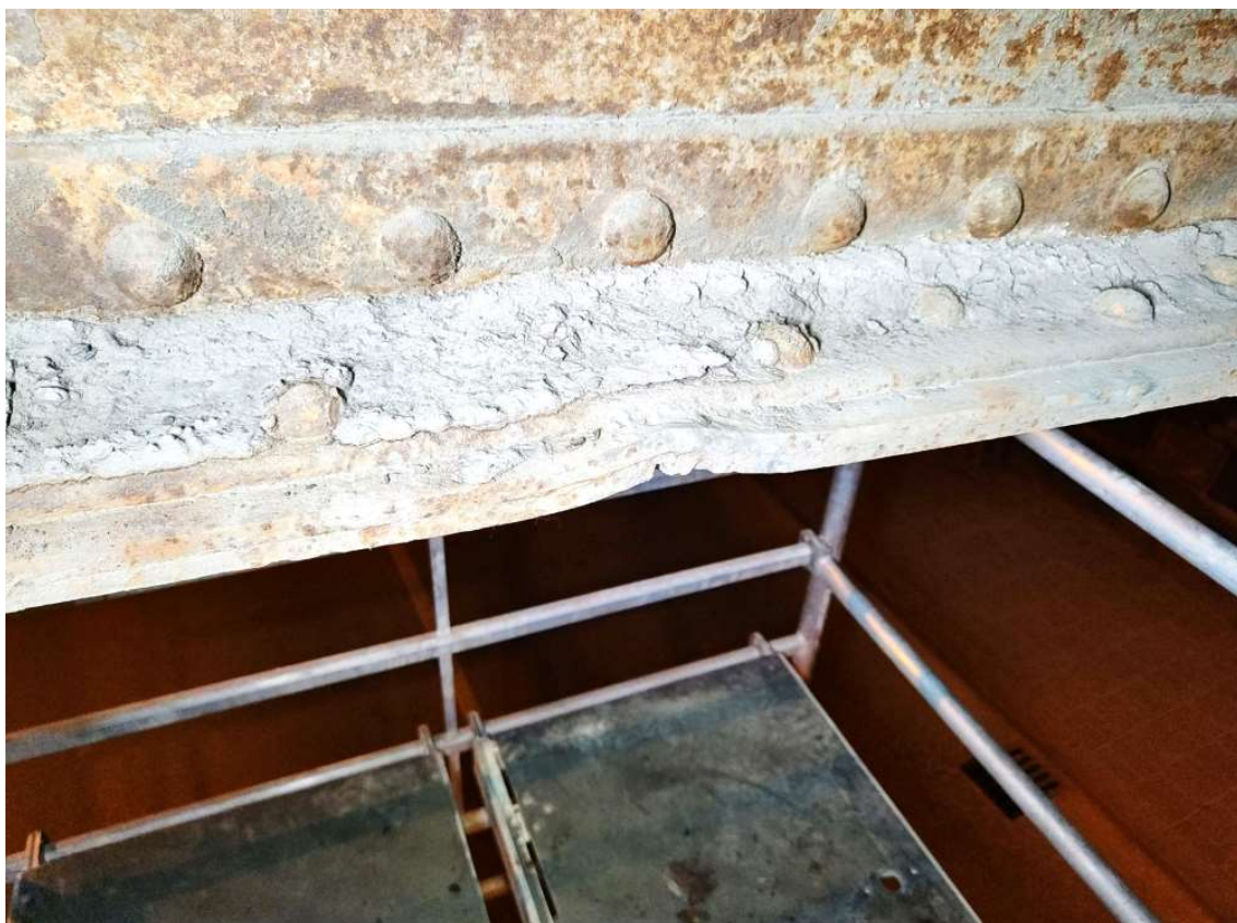
Obrázek 56 K04-Z17 Deformace spodního pasu hlavního nosníku 15x5 cm – délka deformace 2 cm
