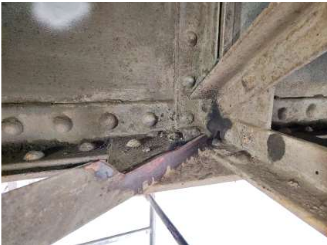
Obr. 57 Odběr oceli na brzdém ztužidle konstrukce K02 – U2
