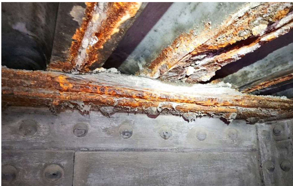
Obrázek 34 K02-Z02 – Horní pás hl. nosníku – 60x15 cm – úbytek až 4 mm
