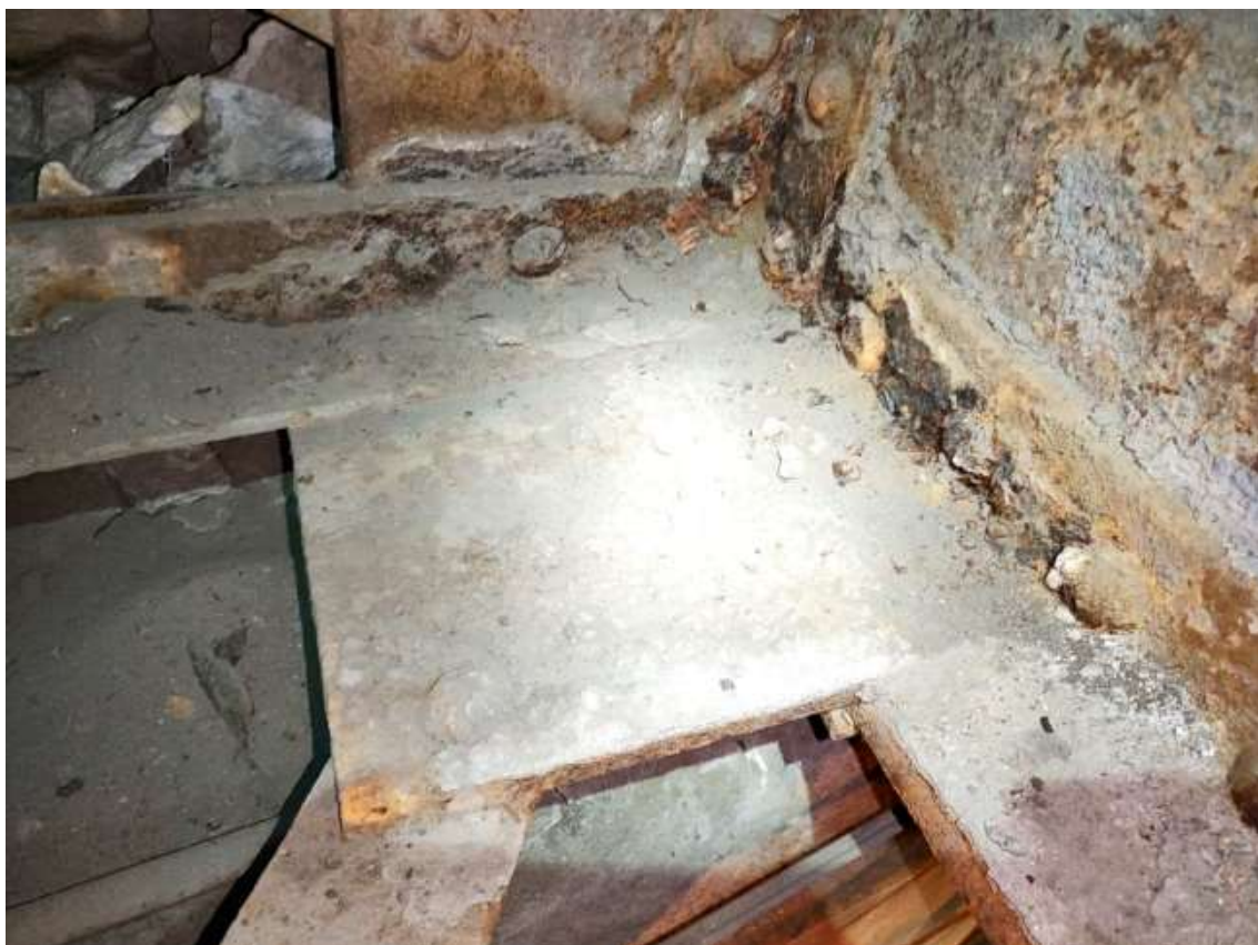
Obrázek 47 K04-Z09 Spojník hl. nosníku a 1. příčnicku – úbytek 3mm poškozených 15 hlav nýtů
