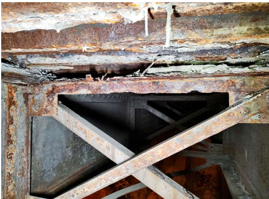
Obrázek 53 K04-Z14 Horní pás 5. příčniku – koroze pásnice – chybí stojina – poškození do ostra
