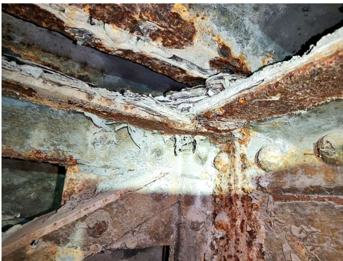
Obrázek 49 K04-Z11 Horní pás 1. příčnicku – plátková koroze v délce 30 cm – nárůst až 2 cm
