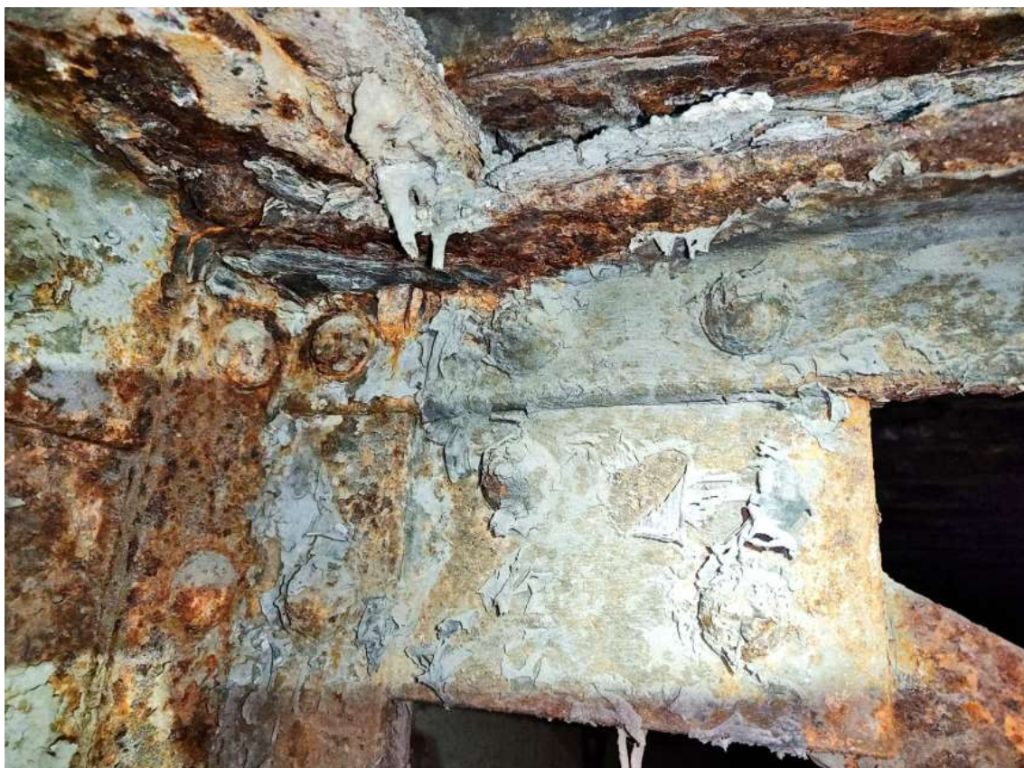
Obrázek 50 K04-Z12 Horní pás 2. příčniku – plátková koroze v délce 30 cm – nárůst 2 cm
