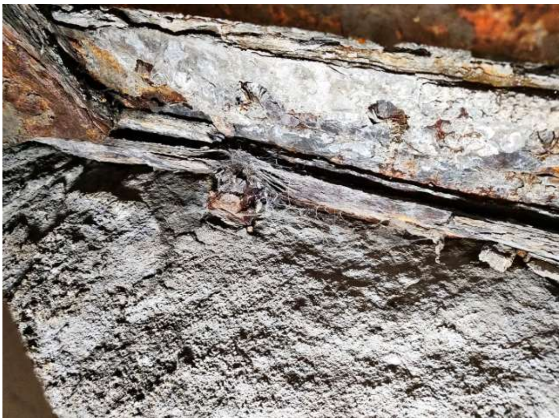
Obrázek 39 K04-Z1 Závěrná zídka – plátková koroze – úbytek 3 mm, chybí všechny hlavy nýtů
