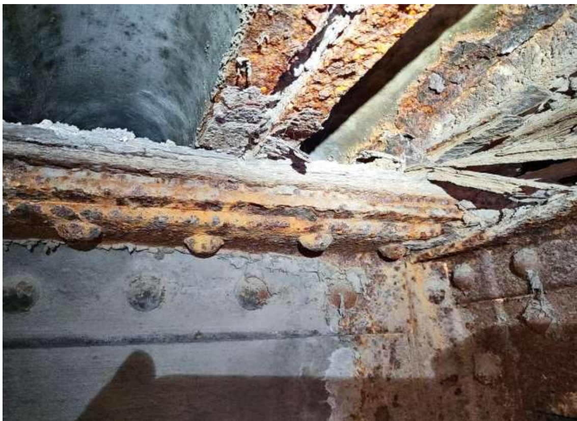
Obrázek 28 K01-Z03 Spoj hlavního nosníku a 5. příčnicku horní pásnice – plátková koroze v délce 130 cm nárůst 3 cm
