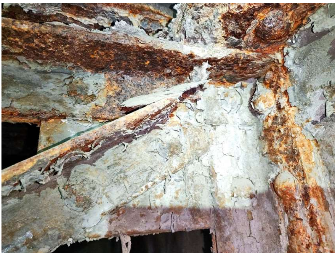
Obrázek 43 K04-Z05 Spojník horní části hl. nosníku a 2. příčníku – 30x5 cm úbytek 3mm
