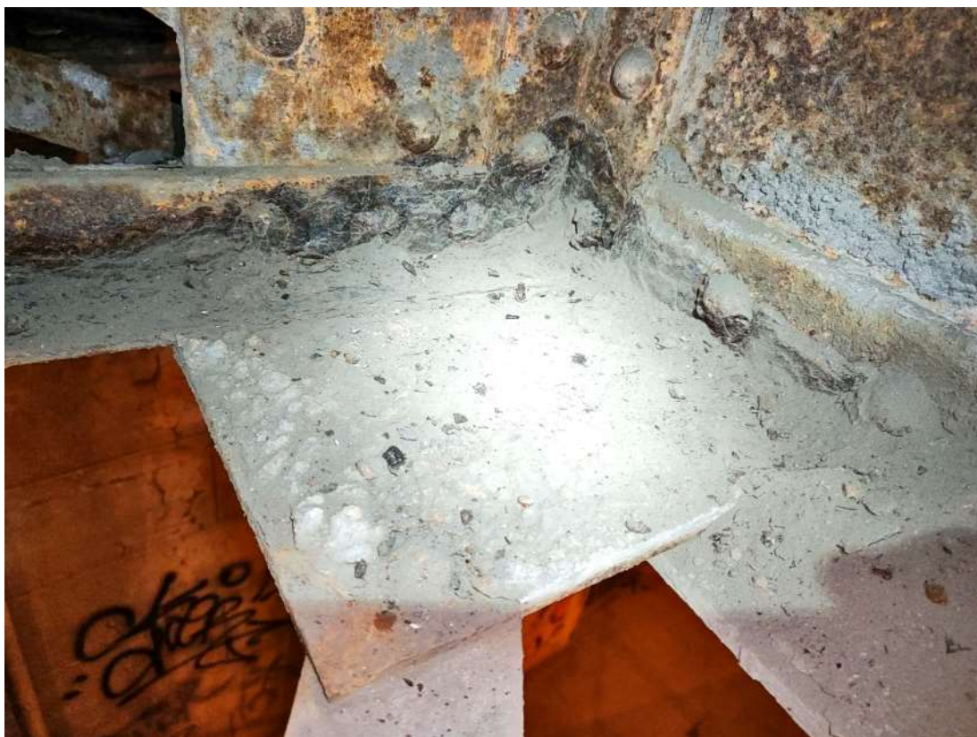
Obrázek 42 K04-Z04 Spojník hl. nosníku a 2. příčníku – koroze celého spojení – úbytek až 3 mm, poškozená hlava nýtu a hl. nos spodní část
