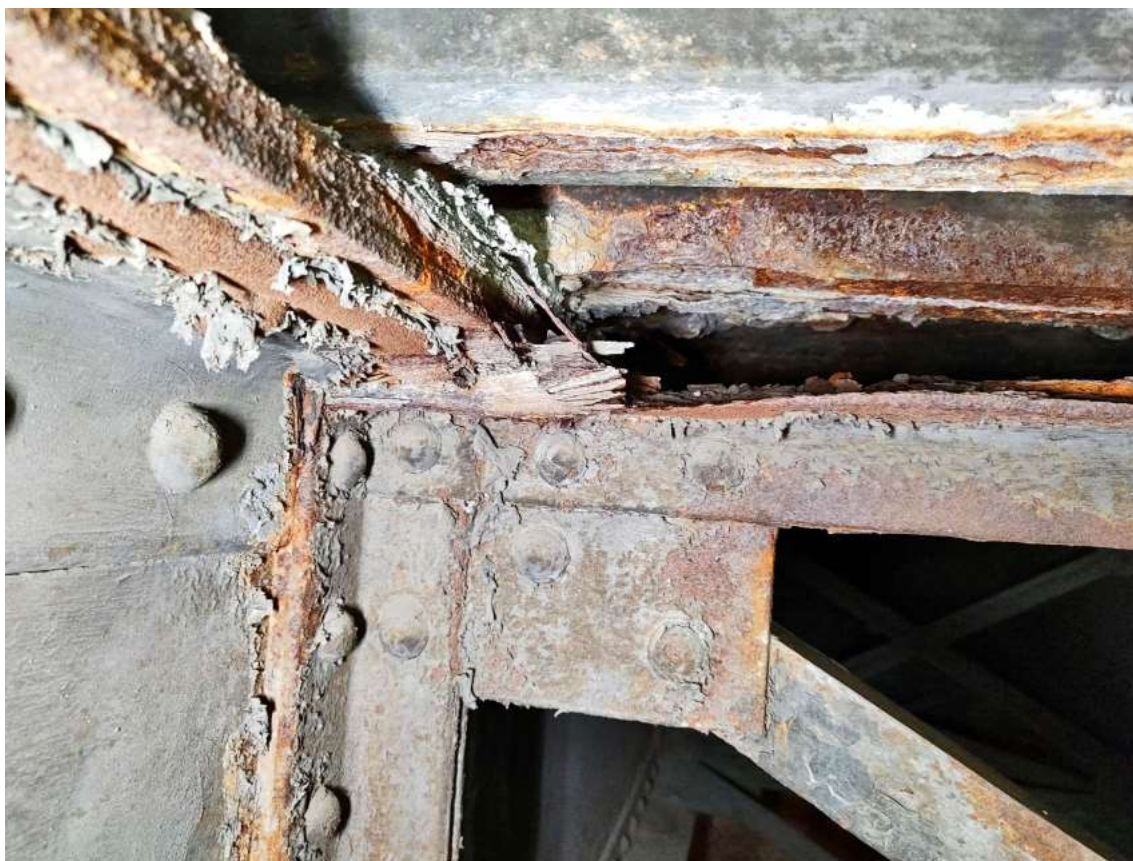
Obrázek 30 K01-Z04 Horní pás hl. nosníku – plátková koroze v délce 5 cm – nárůst 4 cm
