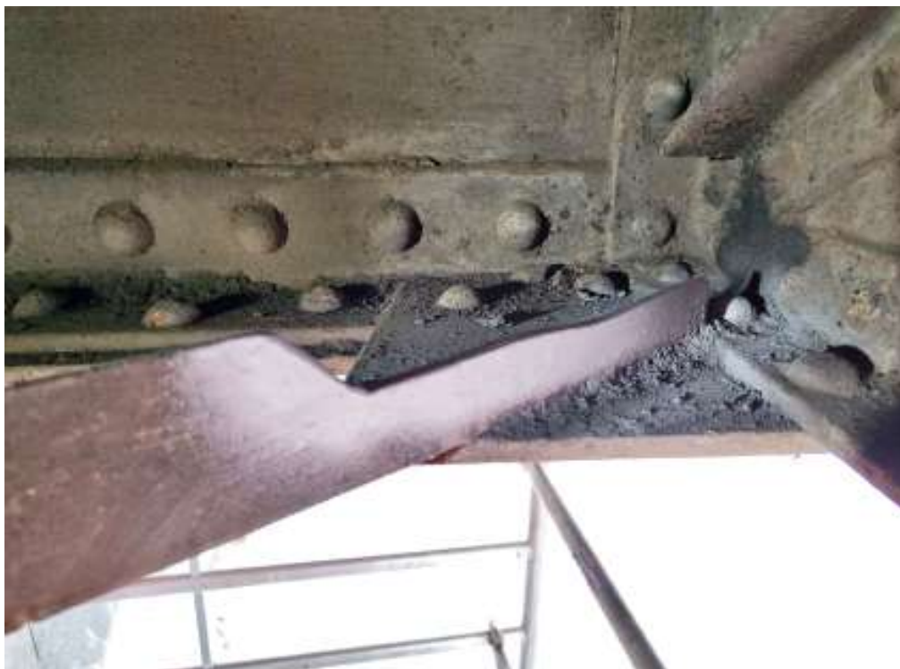
Obr. 58 Odběr oceli na brzdém ztužidle konstrukce K02 – U2
