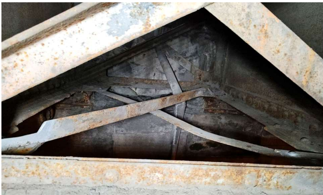
Obrázek 59 K04-Z20 Deformace dolního ztužidla v délce 100 cm
