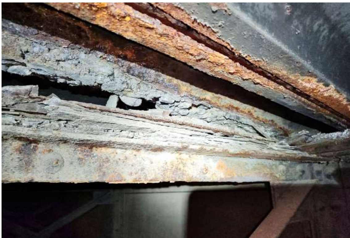
Obrázek 31 K01-Z05 Horní pás hl. nosníku – plátková koroze v délce 70 cm – úbytek až 4 mm
