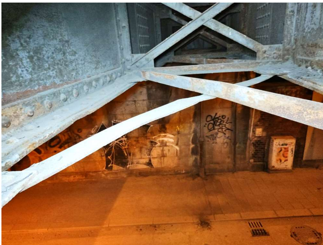
Obrázek 57 K04-Z18 Deformace ztužidla v celé délce
