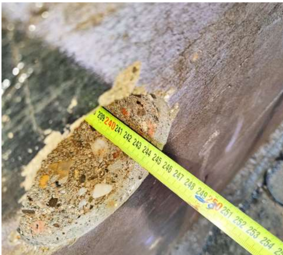
Obrázek 9 Tloušťka opěry O2 je 245 cm
