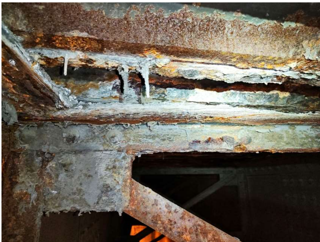
Obrázek 45 K04-Z07 Koroze horního pásu 3. příčniku – koroze plátková v délce 50 cm, nárůst až 3 cm, poškozená stojina 30 cm plátková kor. úbytek až 3 mm
