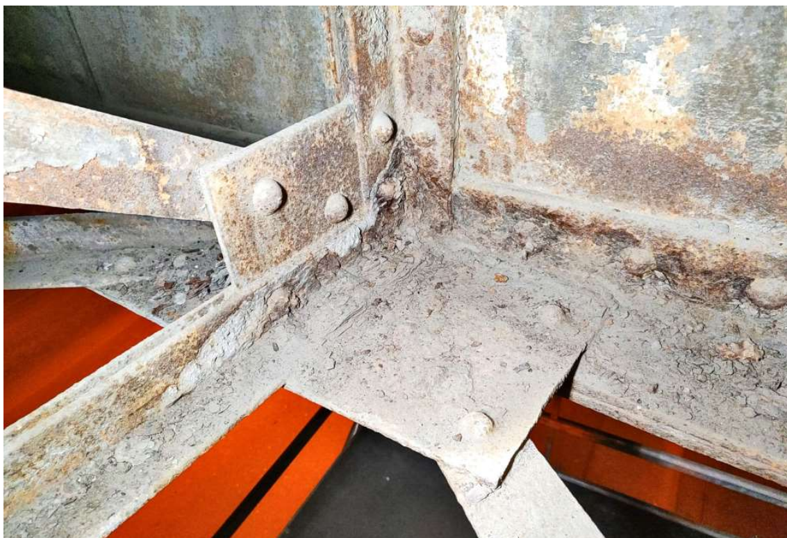
Obrázek 32 K01-Z06 Spodní spojník hl. nosníku a příčnicku – plátková koroze – úbytek 3 mm, poškození 8 hlav nýtů
