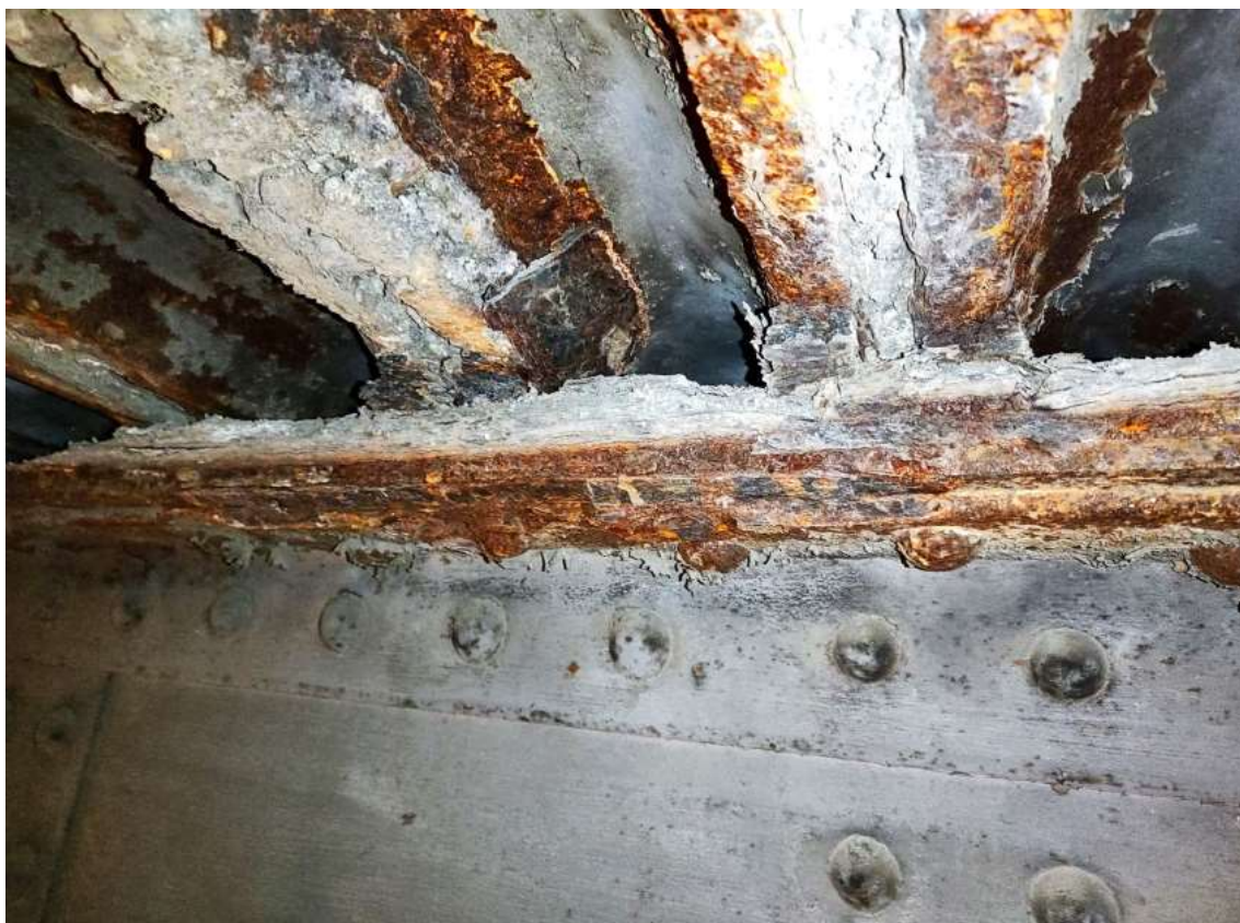
Obrázek 26 K01-Z01 Horní pás hlavního nosníku – zvenku koroze 70x5 cm lokálně úbytek až 6 mm, chybí plech K1-K2
