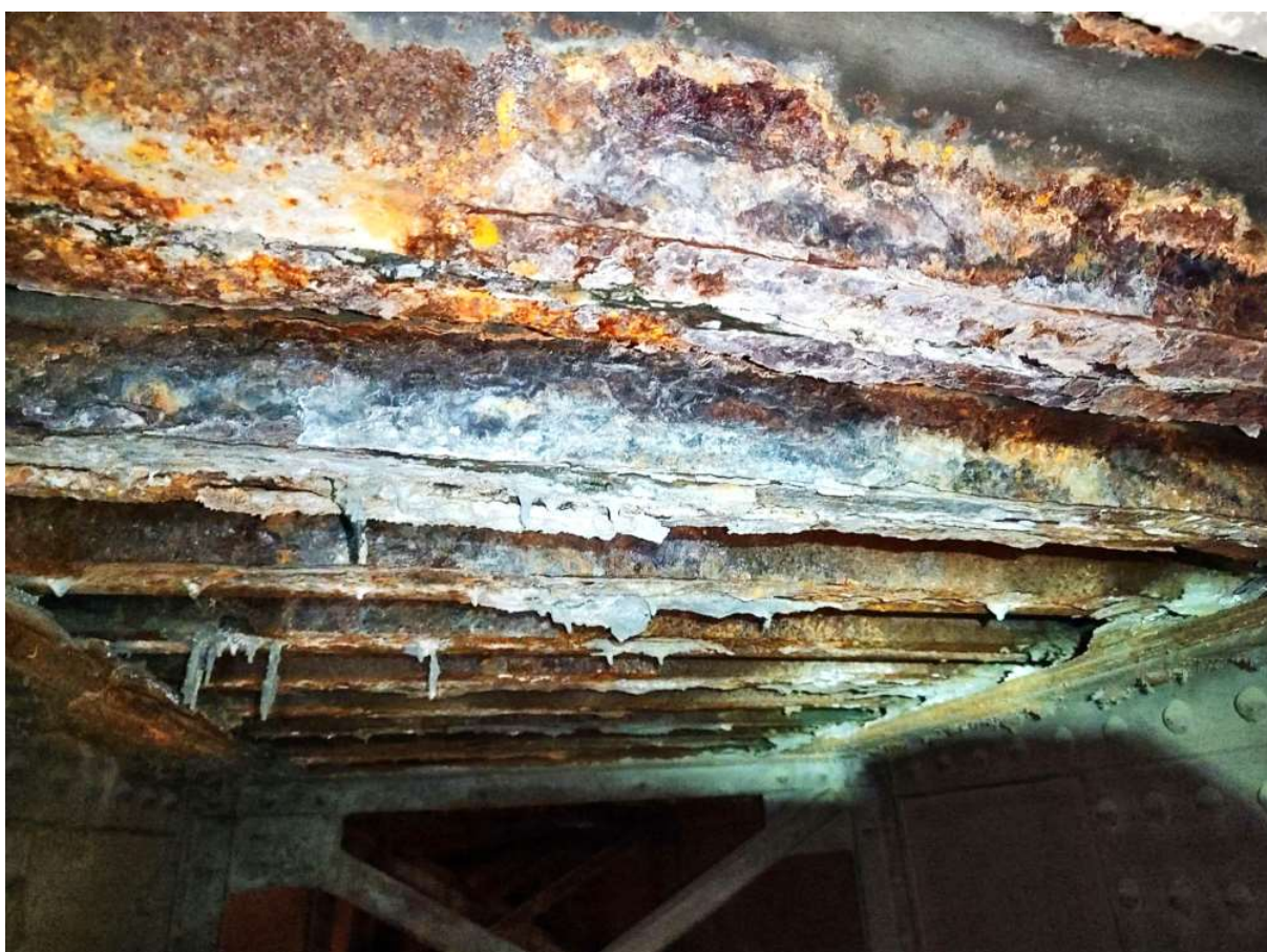
Obrázek 63 P4 – krycí silniční plech nad konstrukcí K04 - celá plocha - lokálně do ostra
