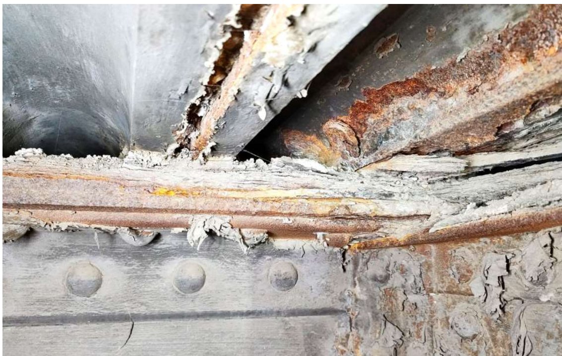
Obrázek 35 K02-Z03 – Horní pás hl. nosníku – plátková koroze v délce 50 cm – úbytek až 4 mm
