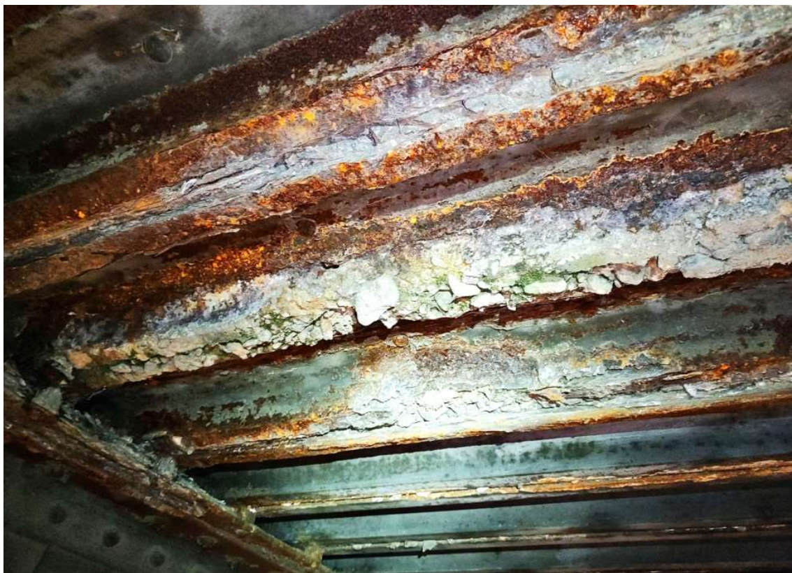
Obrázek 60 P1 – krycí silniční plech mezi konstrukcemi K01 a K02 – 100x60 cm – lokálně do ostra
