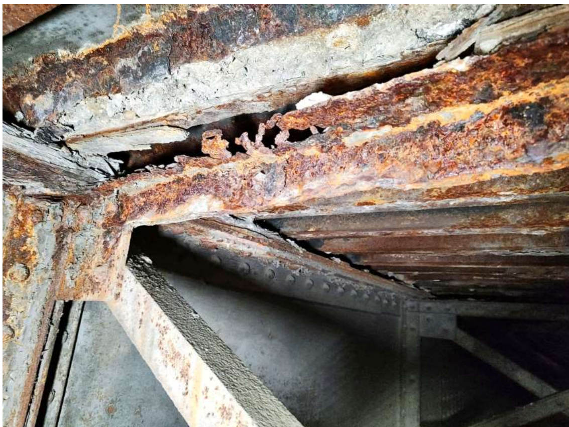
Obrázek 52 K04-Z14 Horní pás 5. příčniku – koroze pásnice – chybí stojina – poškození do ostra
