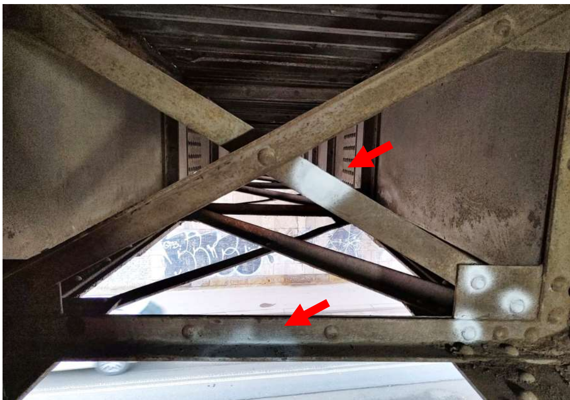
Obr. 51 Tvrdoměrná zkouška ZT7, ZT8
