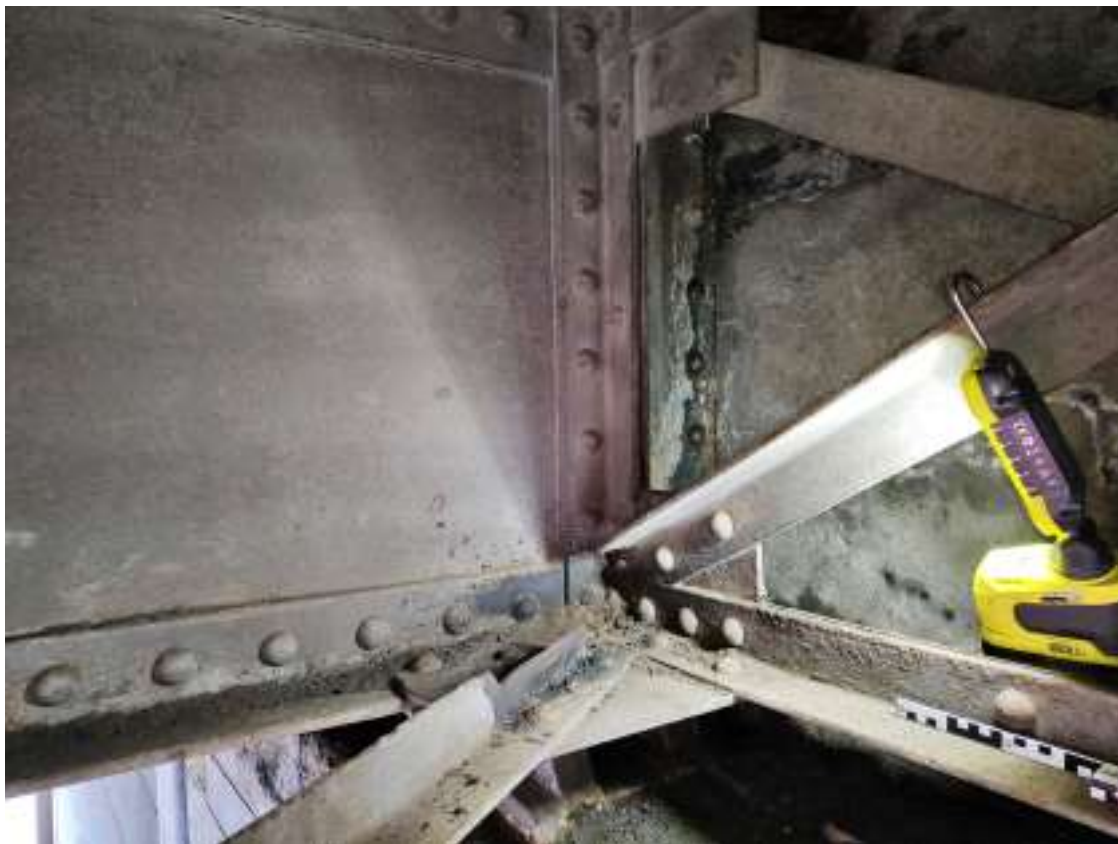
Obr. 55 Odběr oceli na brzdém ztužidle konstrukce K01 – U1
