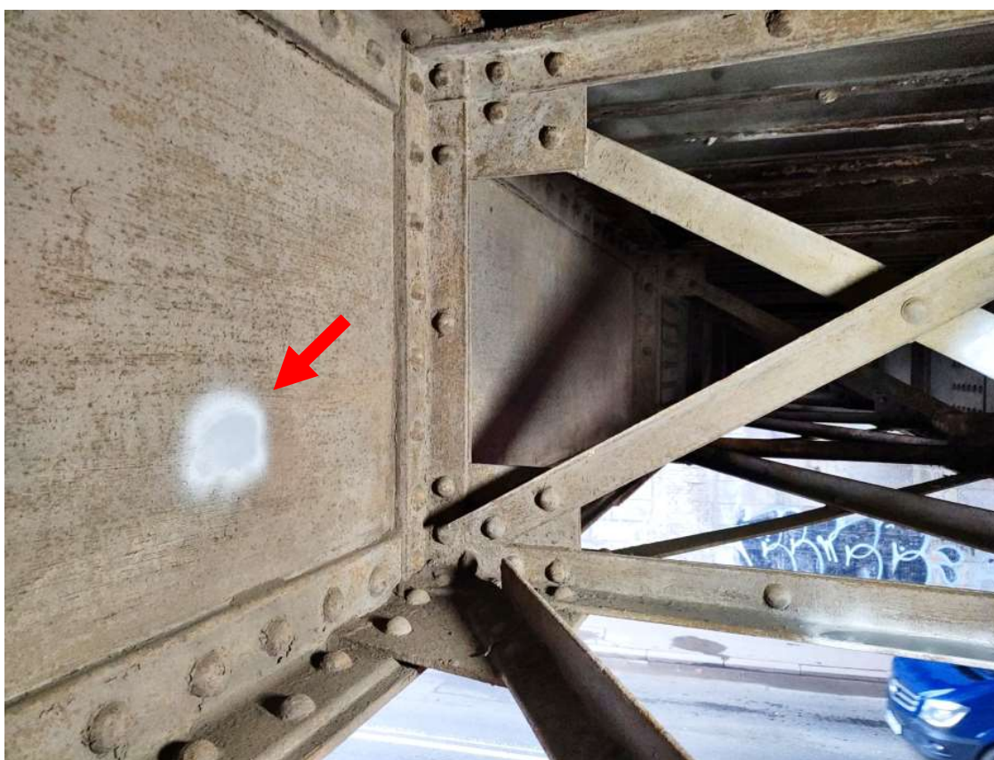
Obr. 52 Tvrdoměrná zkouška ZT9
