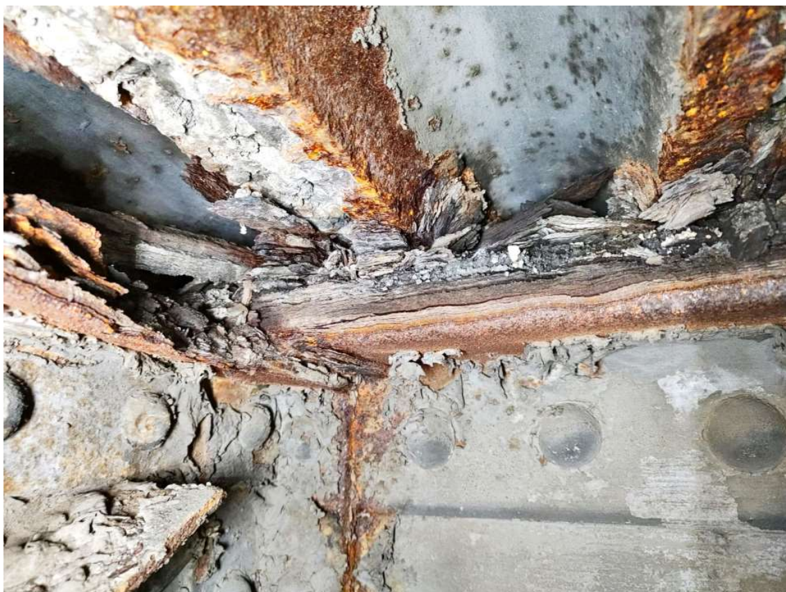
Obrázek 41 K04-Z03 Horní pás hl. nosníku – plátková koroze – úbytek až 4 mm
