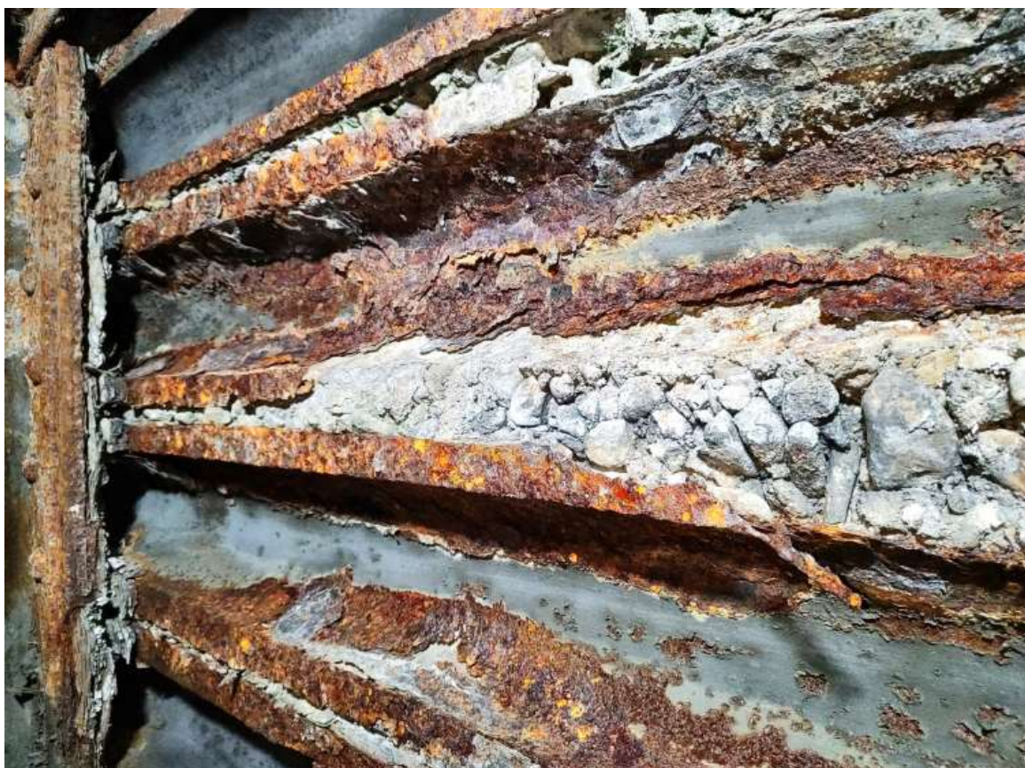
Obrázek 67 P8 - krycí silniční plech nad konstrukcí K04 - chybí celá žebra
