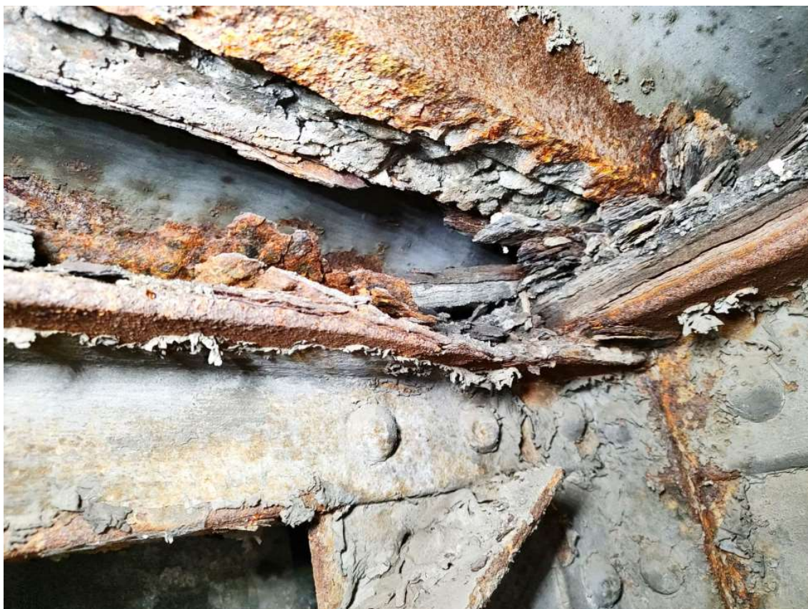
Obrázek 40 K04-Z02 Horní pás 1. styčniku – plocha 3x10 cm do ostra
