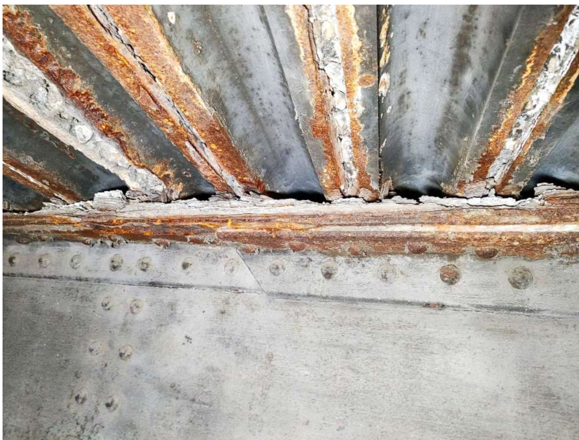
Obrázek 51 K04-Z13 Plátková koroze hor. pásu hl. nosníku v délce 150 cm – nárůst až 4 cm
