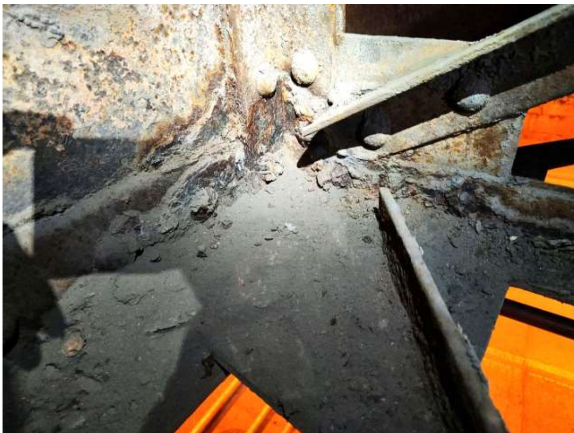
Obrázek 48 K04-Z10 Spojník hl. nosníku a 2. příčnicku – úbytek až 3mm poškozených 13 hlav nýtů
