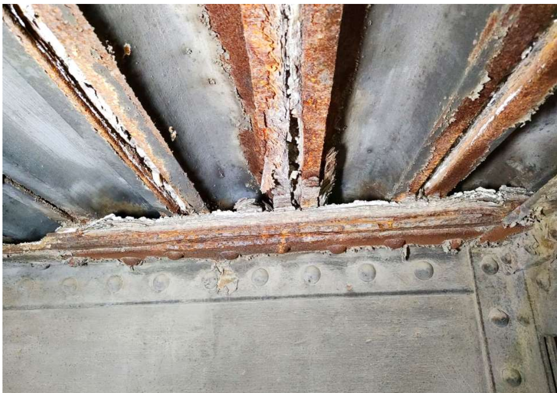
Obrázek 37 K02-Z05 Horní pás hl. nosníku – pásnice v délce 100 cm nárůst 2 cm
