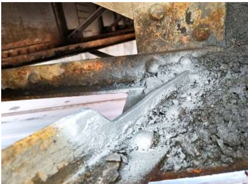
Obr. 61 Odběr oceli na brzdém ztužidle konstrukce K04 – U4
