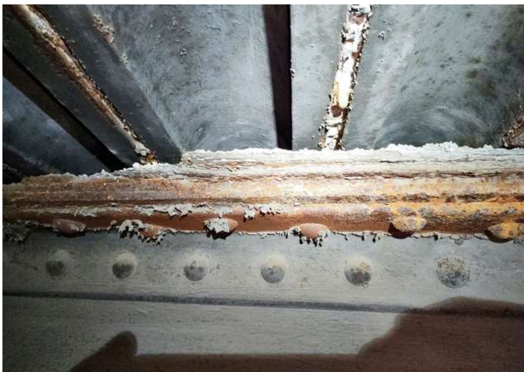
Obrázek 29 K01-Z03 Spoj hlavního nosníku a 5. příčnicku horní pásnice – plátková koroze v délce 130 cm nárůst 3 cm
