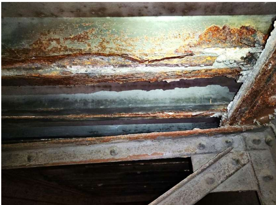
Obrázek 61 P2 - krycí silniční plech nad konstrukcí K01 - 60x15 cm - lokálně do ostra
