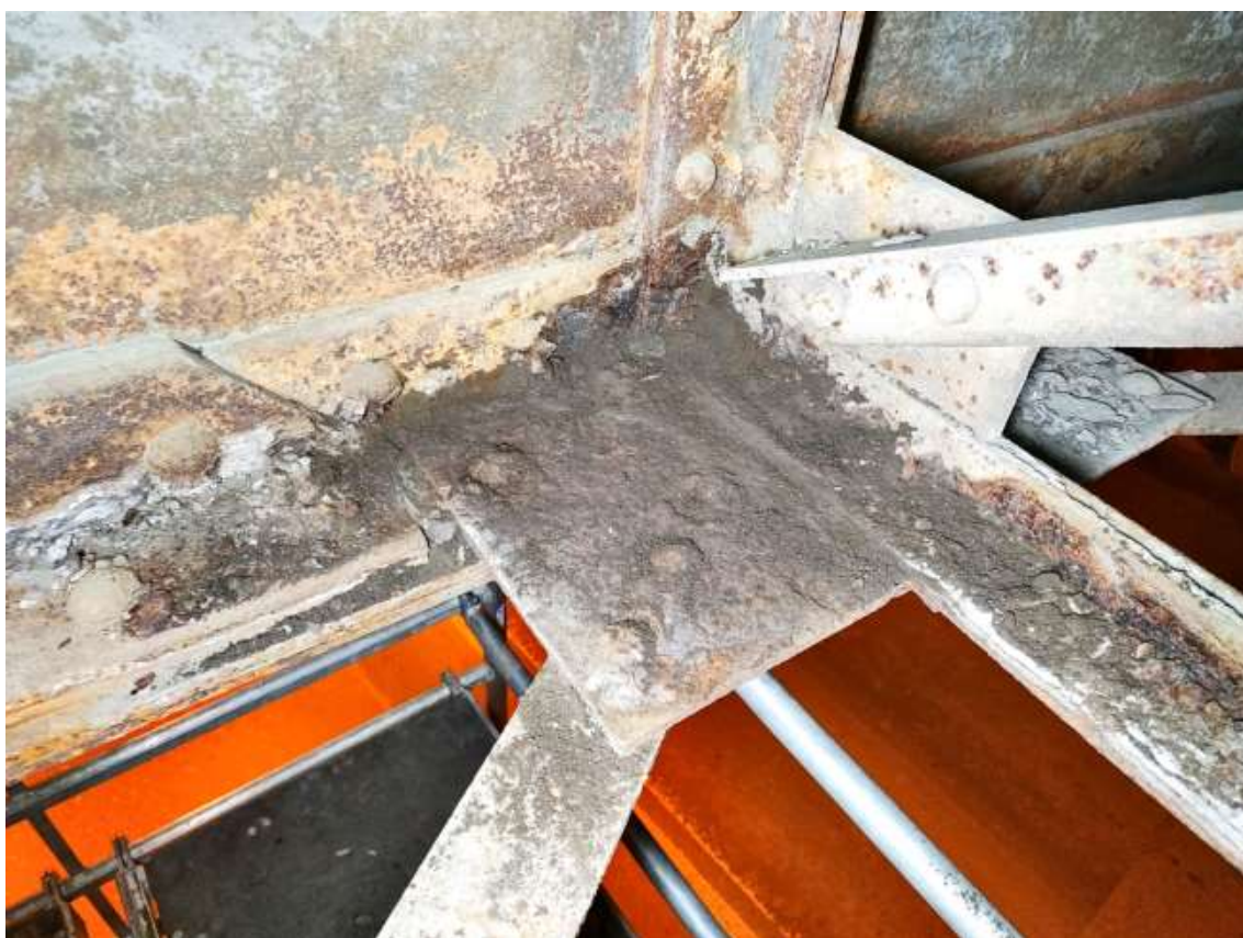
Obrázek 55 K04-Z16 Spodní spojník příčnicku a hl. nosníku – plátková koroze poškozeno 10 hlav nýtů
