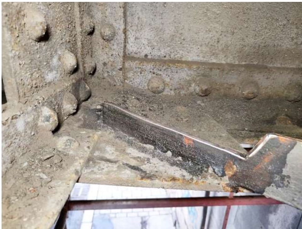
Obr. 59 Odběr oceli na brzdém ztužidle konstrukce K03 – U3
