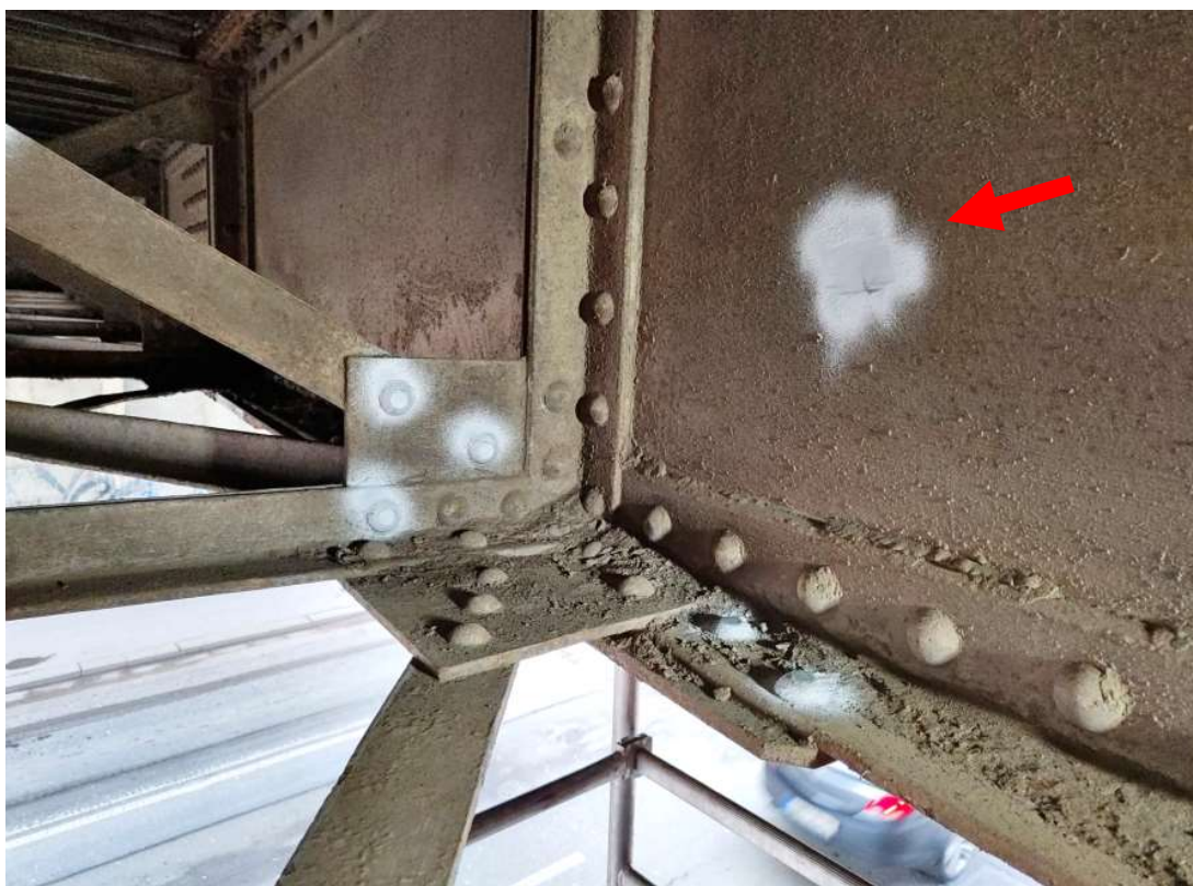
Obr. 50 Tvrdoměrná zkouška ZT6
