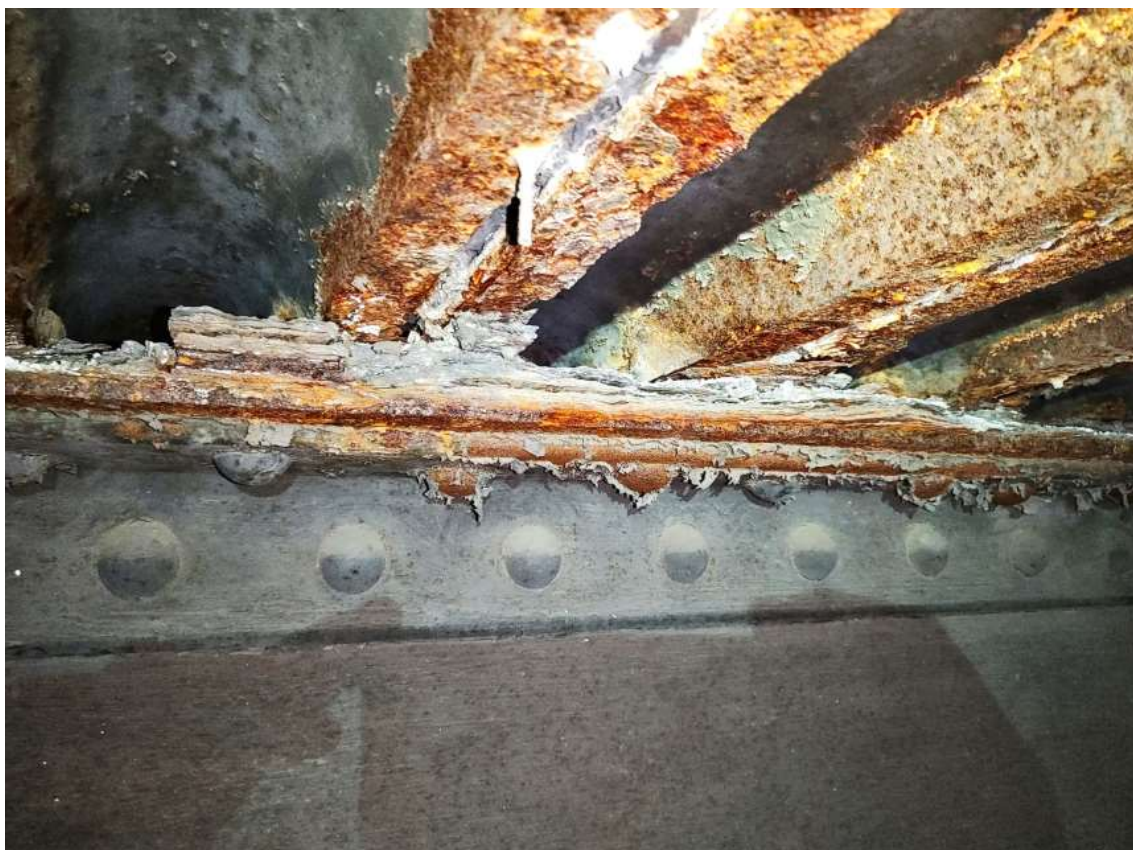
Obrázek 46 K04-Z08 Plátková koroze hor. pásu hl. nosníku v délce 50 cm nárůst až 4 cm
