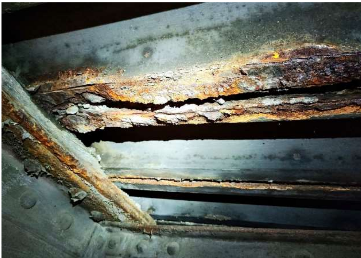
Obrázek 62 P3 - krycí silniční plech nad konstrukcí K02 - 60x15 cm - lokálně do ostra
