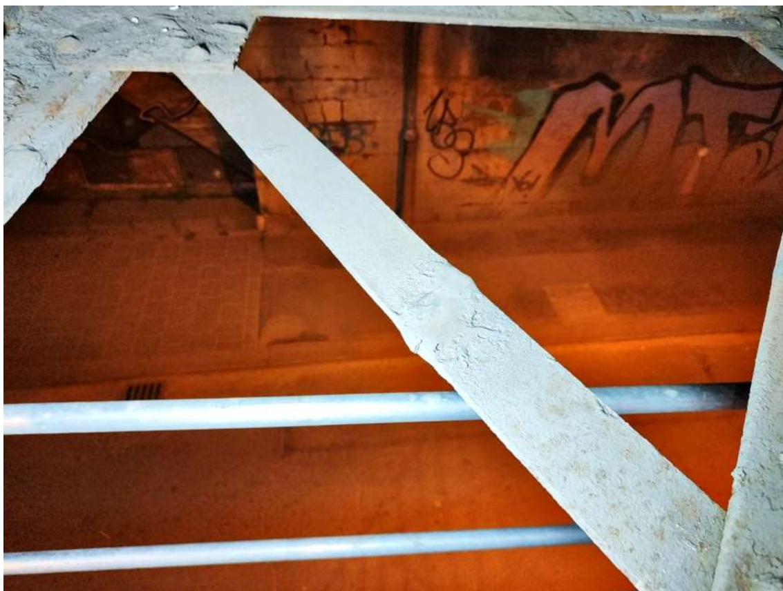
Obrázek 58 K04-Z19 Spodní ztužidlo svažené v celém profilu
