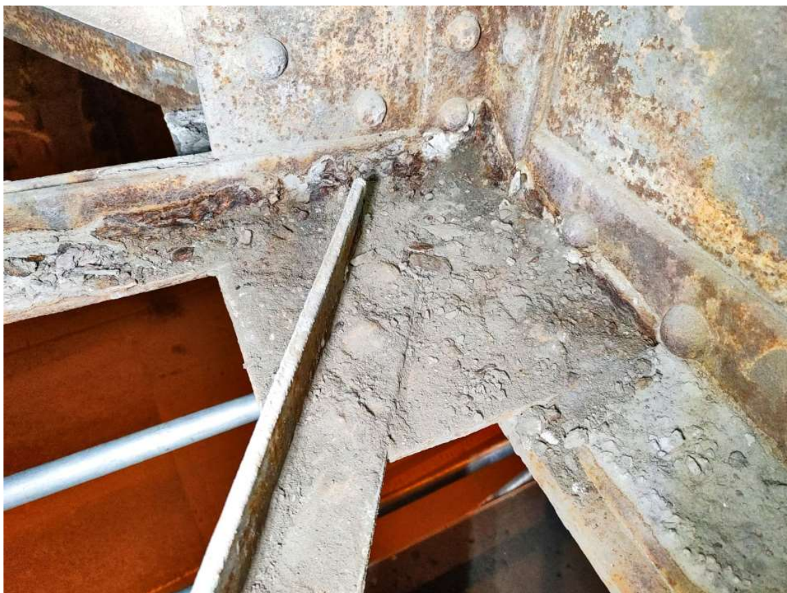
Obrázek 54 K04-Z15 Spodní spojník 5. příčnicku a hl. nosníku – plátková koroze poškozeno 9 hlav nýtů
