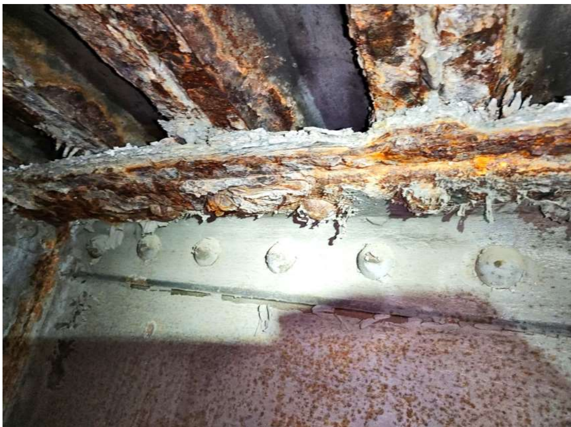
Obrázek 44 Koroze hor. pásu hl. nosníku v průběhu celé konstrukce přes celá pole
