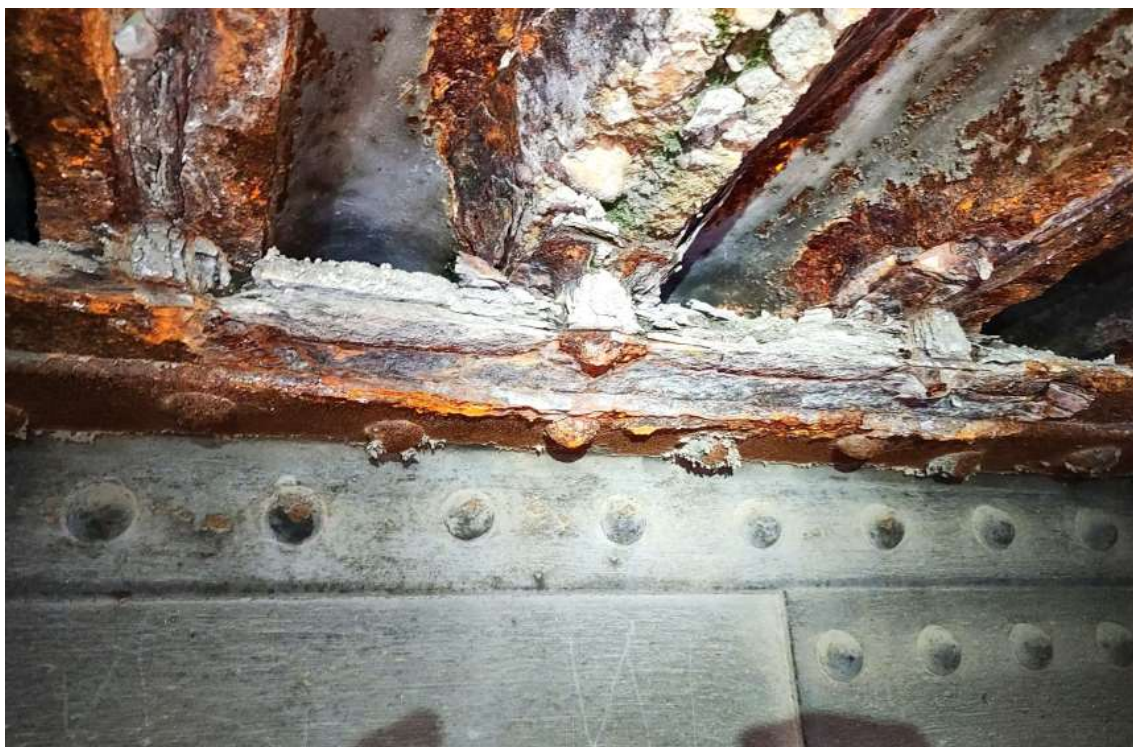
Obrázek 33 K02-Z01 Horní pás hl. nosníku zvenku – kor. plátková 70x5 cm poškozeny 3 hlavy nýtů
